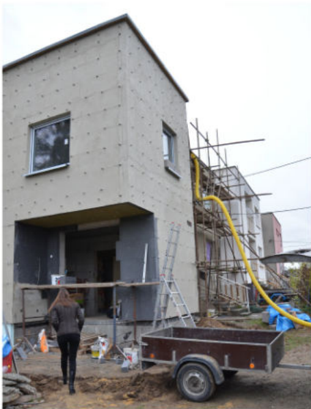
REFERENČNÝ PŘÍKLAD KU KOTVÁM PRO FAŠADNÝ ROŠT
